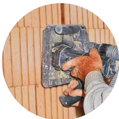
Saignée creusée à la rainureuse
