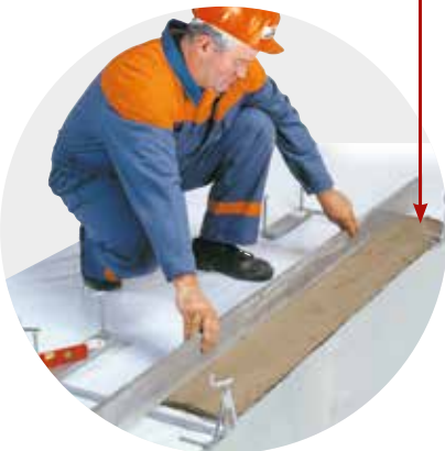
Arasement du mortier sur platines en bord de plancher
