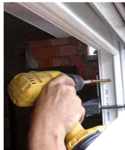
Exemple de fixation à travers le profilé
