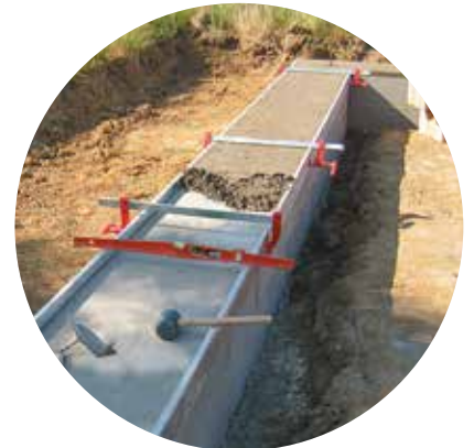
Arasement du mortier sur longrines. Retirer les règles avant pose du 1 er rang de briques.
